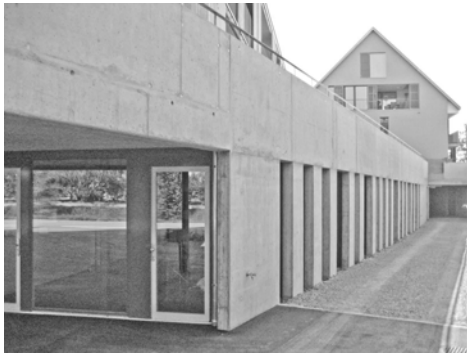
Ansicht Büro Schaffhauserstrasse 24
